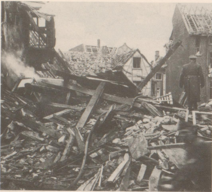
„Kriegsalltag an der Heimatfront“; zerstörte Häuser und Wohnungen nach einem Tagesangriff im März 1944
