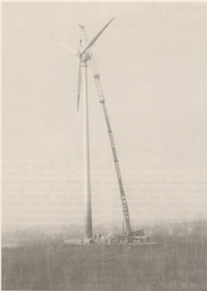
Letzter spektakulärer Akt des Aufbaus war die Montage der Flügel einschließlich Generator an der Mastspitze, die von zahlreichen Zuschauern verfolgt wurde. Foto: L. Rettig
