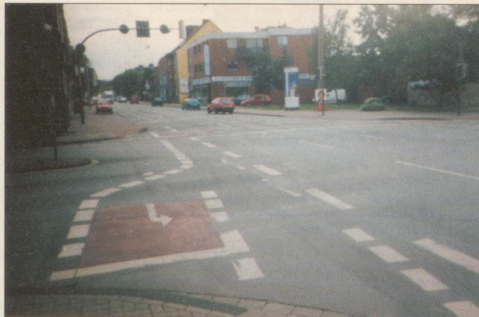
Eine Besonderheit sind die Warteflächen für indirektes Linksabbiegen (Erläuterungen in Text).
