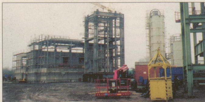
Über Tage sind die Arbeiten für den Förderturm und Nebenanlagen weit fortgeschritten.
