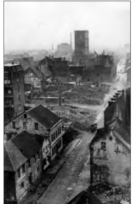
Die stark beschädigte Pauluskirche.
