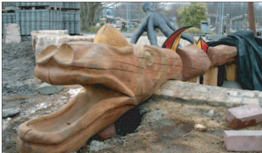
Kreatives aus Holz: Die wasserspeiende Schlange während der Montage.
