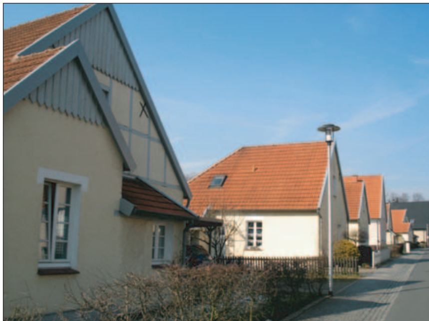
Siedlung Zechenbahnweg: „Geschlossene Struktur von hoher Qualität.“
