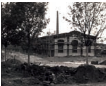
Baustelle vor der Werkstatthalle.
