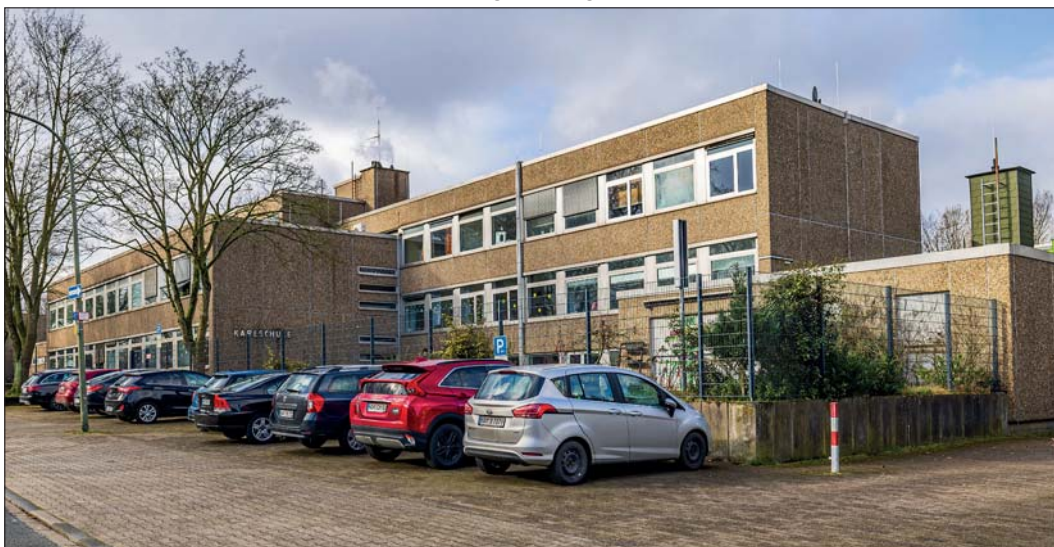
Die Karlschule im Hammer Norden ist stark sanierungsbedürftig
