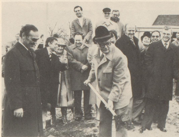
Erster Spatenstich für das DRK-Altenzentrum an der Marker Allee.
