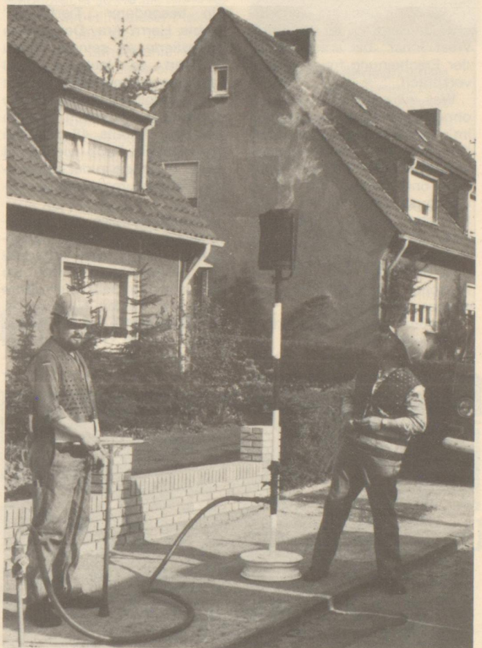
Erdgasumstellung in Bockum-Hövel 1981: Das Kokereigas wird abgefackelt.
