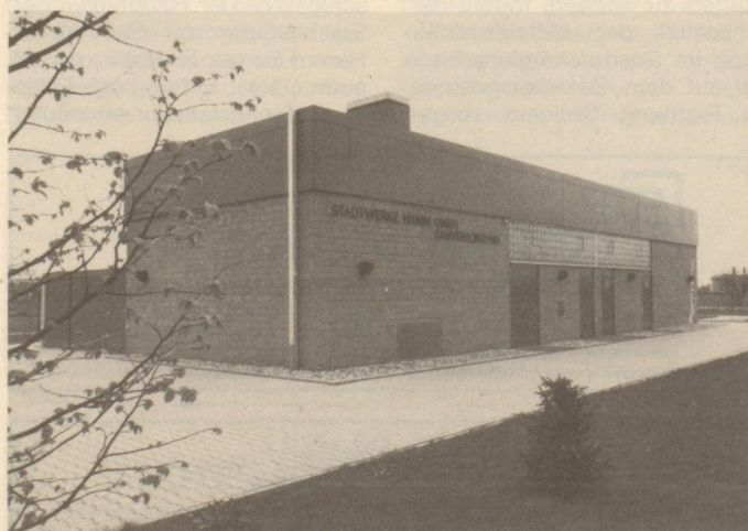
Erdgas-Übernahmestation in Uentrop.
