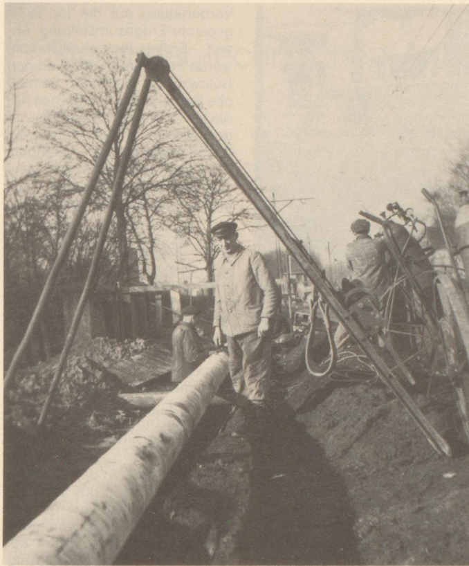
Bau einer Gasbezugsleitung an der Hammer Straße in Bockum-Hövel im Jahr 1949.
