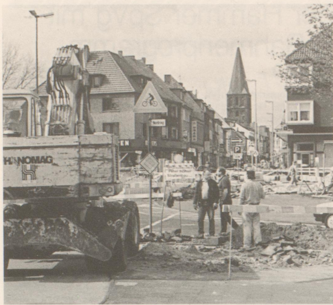
Die Versorgungsunternehmen haben mit dem Verlegen von Leitungen in der Oststraße im Vorgriff auf den Umbau begonnen.
