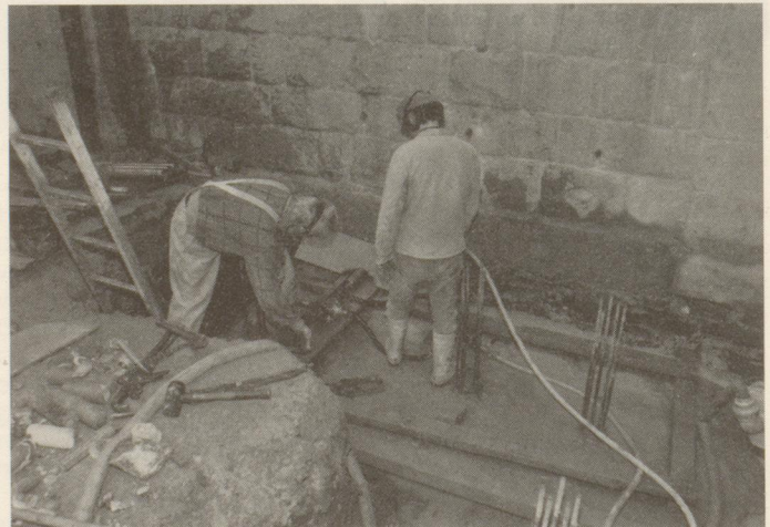
Das Fundament der Lutherkirche mußte unterfangen werden.
