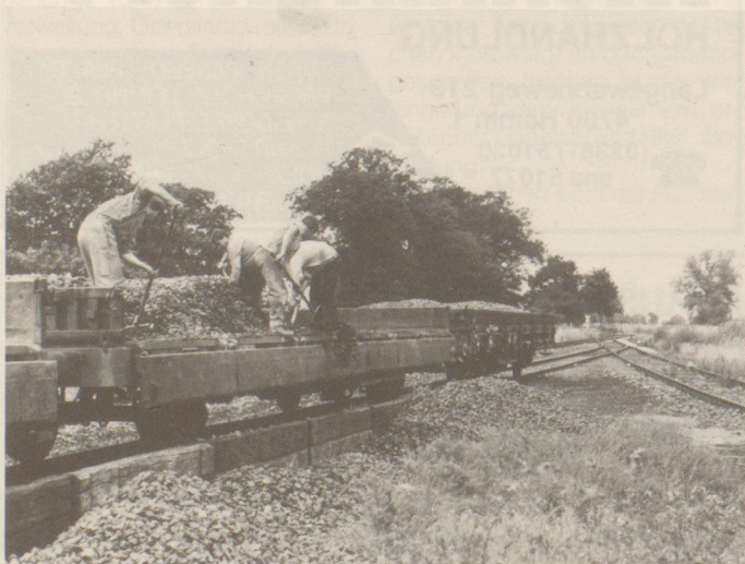
Neuer Schotter für das Gleisbett schließt die Sanierung ab.
