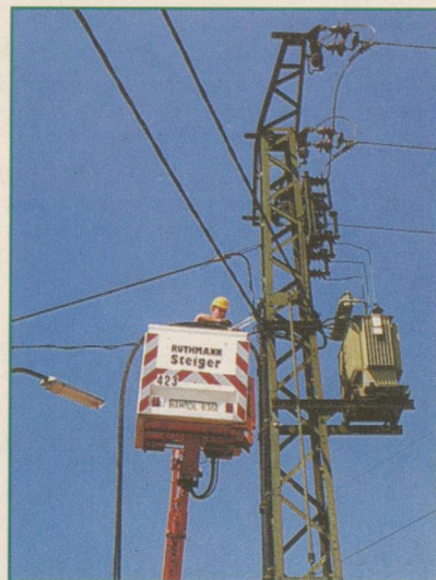
Mit dem Steigerfahrzeug der Stromversorgung hoch hinaus.
