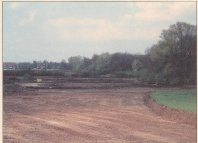
Die neue Trasse der Werler Straße (B 63), die kurz hinter der Dr. Loeb-Caldenhof-Straße nach Osten abschwinkt, um dann über einen Damm und zwei Brücken die Bahnlinien zu überqueren, ist schon Richtung Norden gut erkennbar. Der Baubeginn zur Bahnübergangs-Beseitigung wird am Freitag, 3. Mai feierlich begangen.
