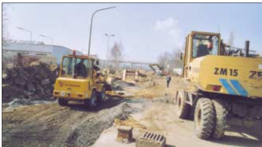
Im ersten Bauabschnitt wird die Hafenstraße nach Westen verlängert.
