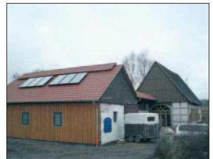
Zweites Element: Eine Solaranlage.
