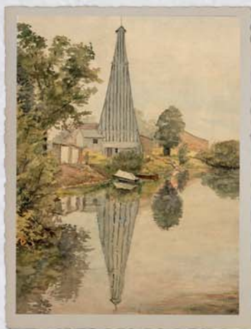
Alter Sole-Bohrturm Hamm,
