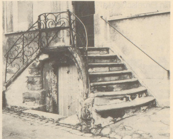
Freitreppe vor der Restaurierung
