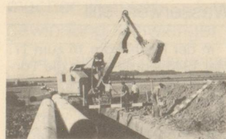
Bau einer Transportleitung DN 800/700 vom Haarstrang nach Hamm.
