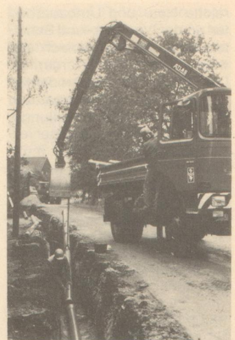
Rohrnetzdienst im Einsatz.
