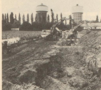
Bau einer Stadt-Transportleitung DN 700 Berge — Grüner Weg.
