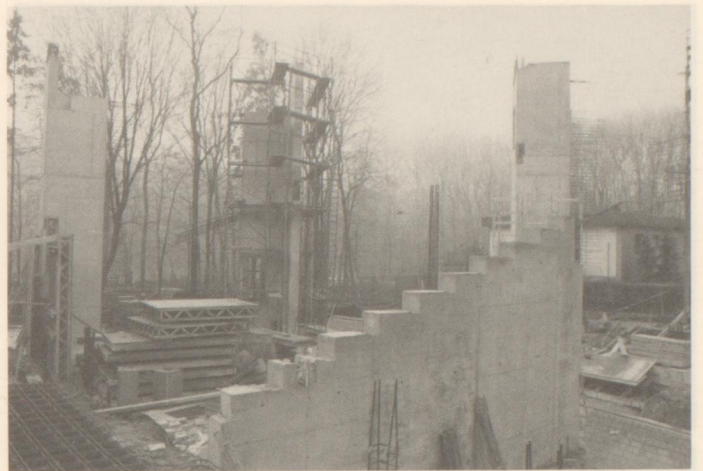
Die Baustelle im Morgennebel des 4. Februars 1993.
