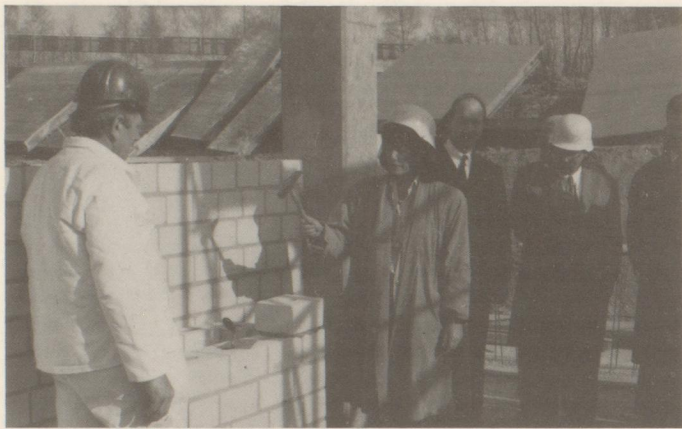
Am 19. März 1993 legte die damalige Oberbürgermeisterin Sabine Zech den Grundstein für den Neubau der Hauptfeuerwache
