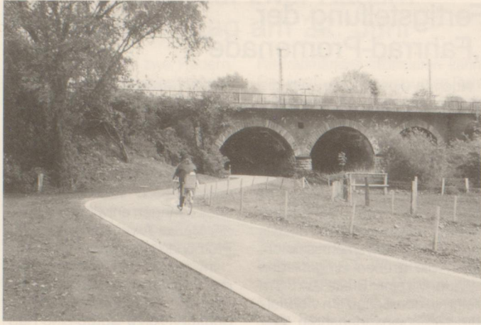
Eine Autofreie Radverbindung durch die Kornmersch zwischen Bromberger und Münsterstraße wurde vor kurzem geschlossen.
