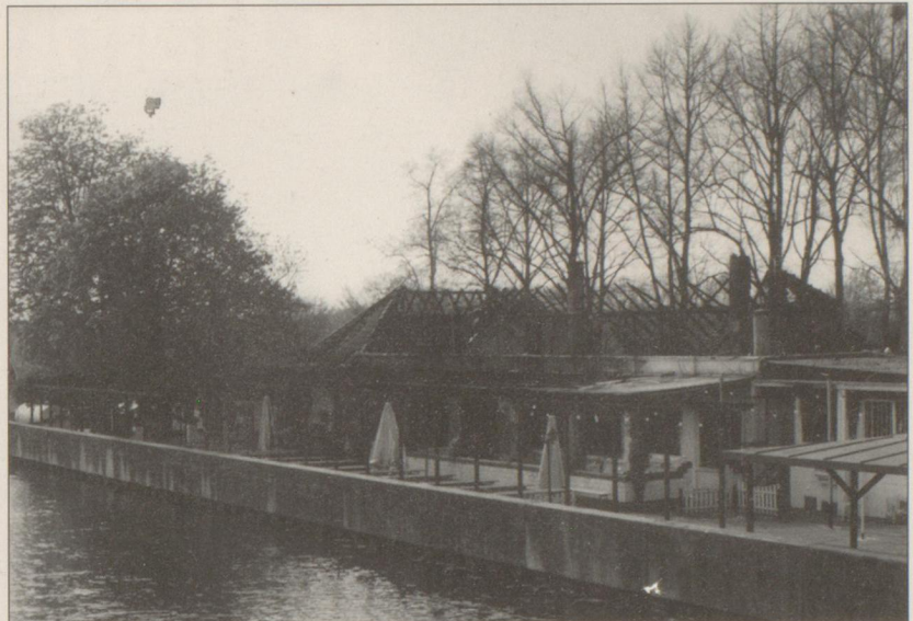
Zwei Großbrände richteten in der letzten Zeit Schäden in Millionenhöhe an. In den frühen Morgenstunden des 18. April war ein defekter Kühlschrank die Ursache für das verheerende Feuer, dem das Bootshaus an der Fährstraße zum Opfer fiel. Nur noch die Außenmauern und ein größtenteils verbrannter Dachstuhl erinnern an das beliebte Ausflugslokal am Datteln-Hamm-Kanal.
