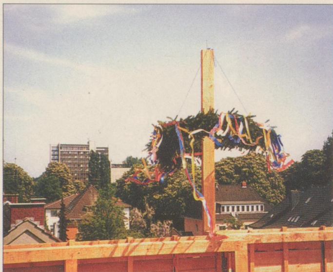
Ein Richtkranz hängt über der Stadt am Ostenwall in direkter Nähe zum Stadtzentrum. Dort errichtet der Kreisverband Hamm e.V. des Deutschen Roten Kreuzes ein Gebäude mit 37 Altenwohnungen, davon neun rollstuhlgerichtet, und mit der Geschäftsstelle des DRK. Zu den Wohnungen gehört eine Sozialstation, die auf Wunsch eine Betreuung der Bewohner anbietet, sowie eine Altentagesstätte mit Cafébetrieb. Mit der Planung sind die Hammer Architekten und Stadtplaner Berendt-Schwinde und Teigelkötter beauftragt.
