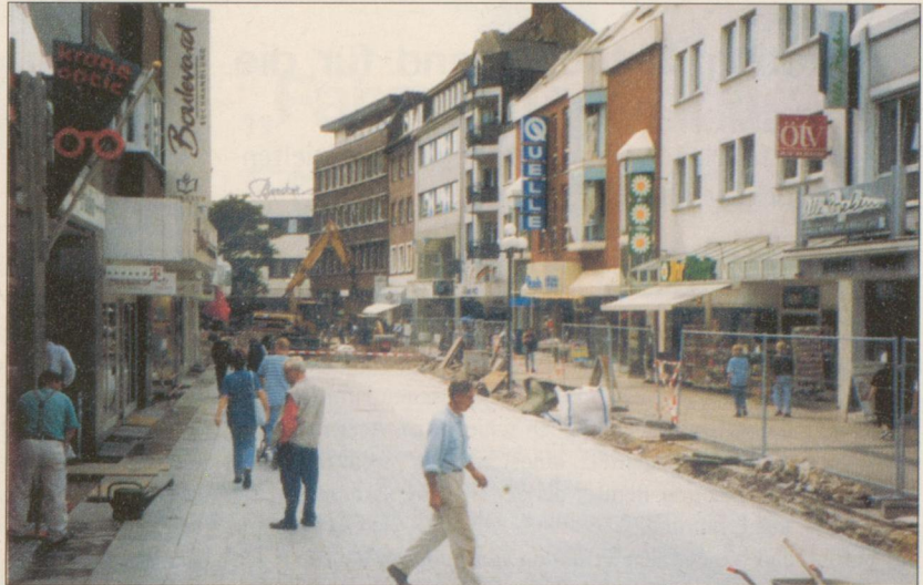
Bauarbeiten behindern in diesem Sommer die Fußgänger in der Weststraße. Belohnt wird die Geduld der Passanten und Geschäftsleute aber mit einem neuen, optisch ansprechenderen Belag. Erneuert wird auch der Abwasserkanal.
