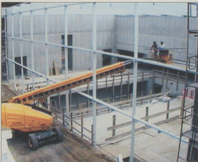
Die Kurhaus-Baustelle am 24. Mai 2002 unter www.hamm.de .
