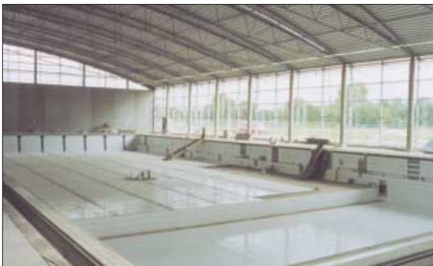
Kurz vor der Vollendung: das 50-Meter-Becken in der Erlebnistherme Bad Hamm, die im November eröffnet wird.
