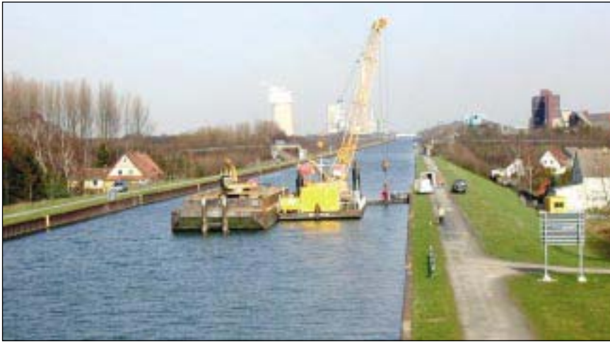
Die Vertiefung des Datteln-Hamm-Kanals ist ein Schwerpunkt des Ausbaus.
