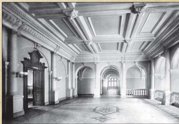
Blick in das Foyer des 1894 eingeweihten OLG-Gebäudes
