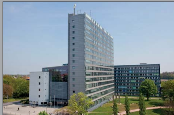
Von 1999 bis 2004 wurde das Oberlandesgericht renoviert und ausgebaut, insgesamt 35.000 Quadratmeter Nutzfläche.
