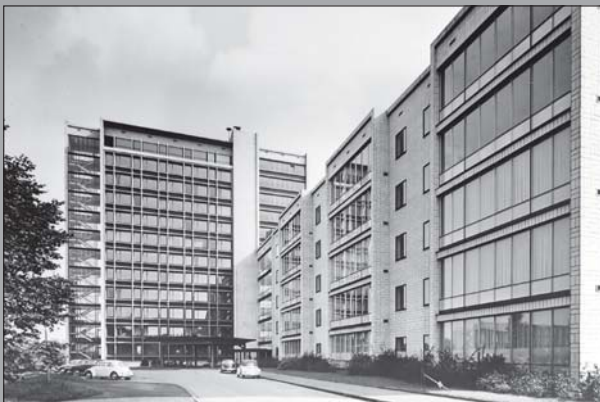
Das neue Oberlandesgerichtsgebäude an der Heßlerstraße, Aufnahme aus dem Jahr 1960
