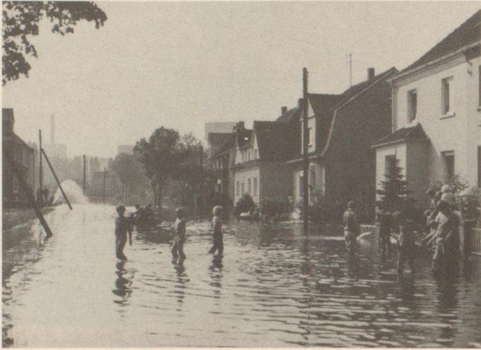
Überflutete Straßen und vollgelaufene Keller waren die Folge der Überschwemmung im Bereich des Wiescherbaches.
