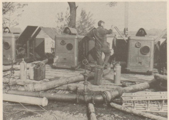
Pioniere der Bundeswehr förderten mit einer leistungsfähigen Pumpanlage in kurzer Zeit die Wassermassen aus dem Überschwemmungsgebiet.
