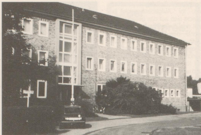
Zollamt Hamm, Nordstraße 25
