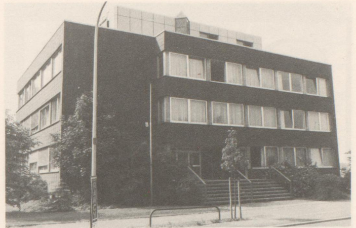
Justizvollzugsamt Hamm, Marker Allee 46
