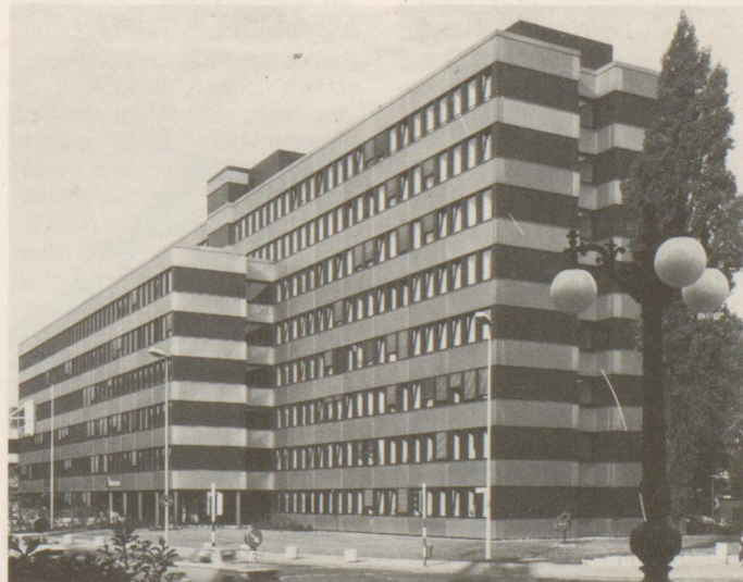
Arbeitsamt Hamm, Bismarckstraße 2
