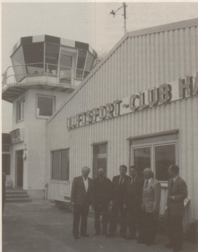
Ende April weihte Verkehrsminister Kniola (3.v.r.) den neuen Tower ein. Begleitet wurde der Minister vom Vors. des Verkehrsausschusses des Landtages, Hemmer, Oberbürgermeister Wieland, Oberstadtdirektor Dr. Kraemer und den Vertretern des Luftsport Club Hamm, Oppenheim (Vors.) und Schwenke (Geschf.)
