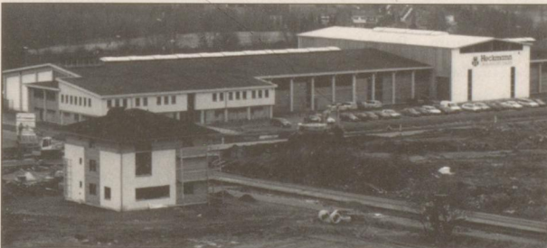
Gegenüber dem geplanten OBI-Baumarkt produziert die Fa. Heckmann seit zwei Jahren erfolgreich Fertighäuser nach Öko-Standards.
