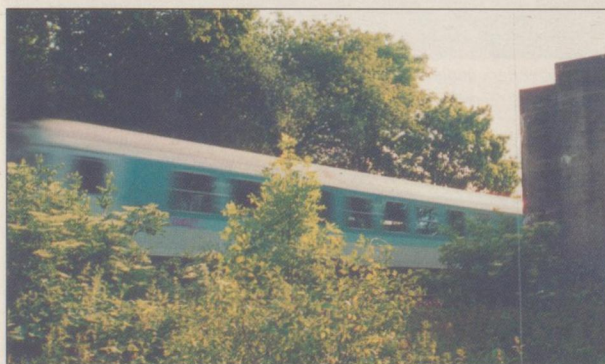
Die Widenlager werden vom Grün überwuchert, die DG AG saust Richtung Soest.
