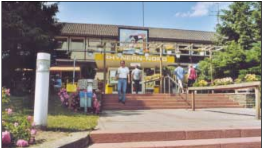
Die Autobahnraststätte Rhynern-Nord wird 2004 komplett neu gebaut.
