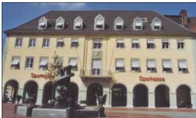
Ein Schmuckstück, die komplett renovierte Hauptstelle der Sparkasse Hamm.
