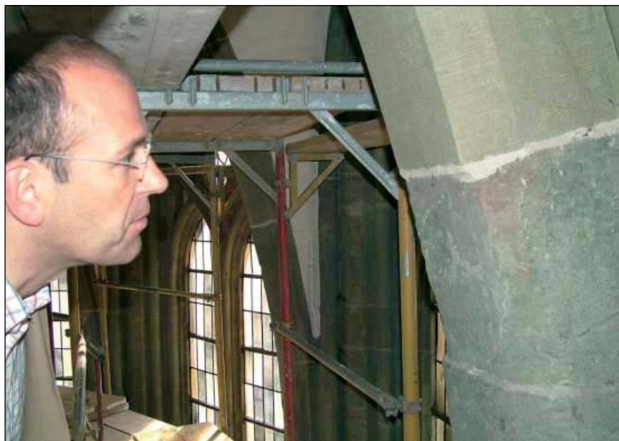
Hat bei der Restaurierung der Pauluskirche alles im Blick: Lutz-Thomas Kusch.
