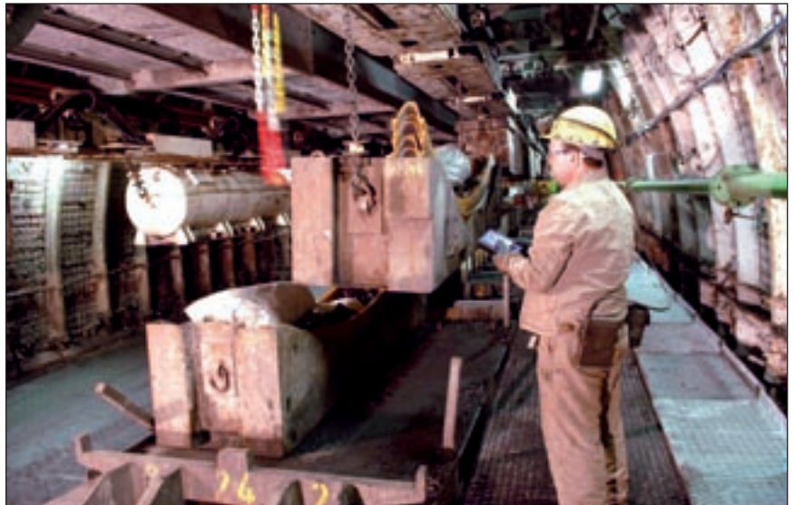
Materialumschlag im Schacht Lerche des Bergwerks Ost.
