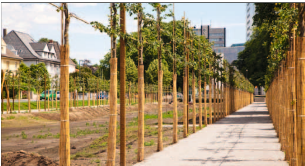
Rekonstruktion: Die Erneuerung des Ostrings orientiert sich an den alten Plänen von 1914.
