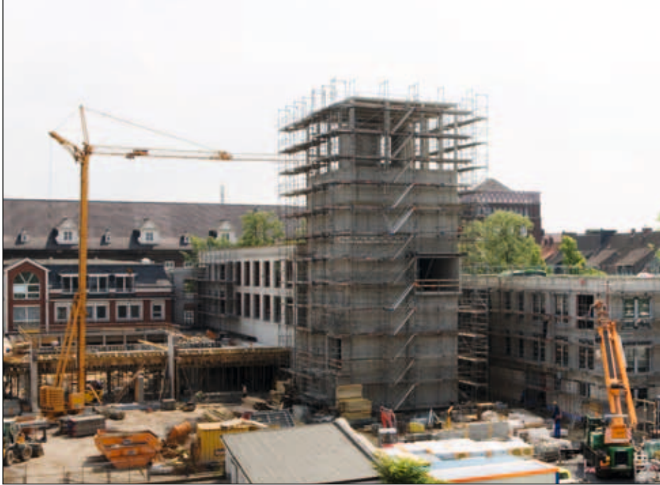
Im Rohbau fertig: Im Frühjahr 2012 soll die Mitgliederoase der Volksbank eingeweiht werden.
