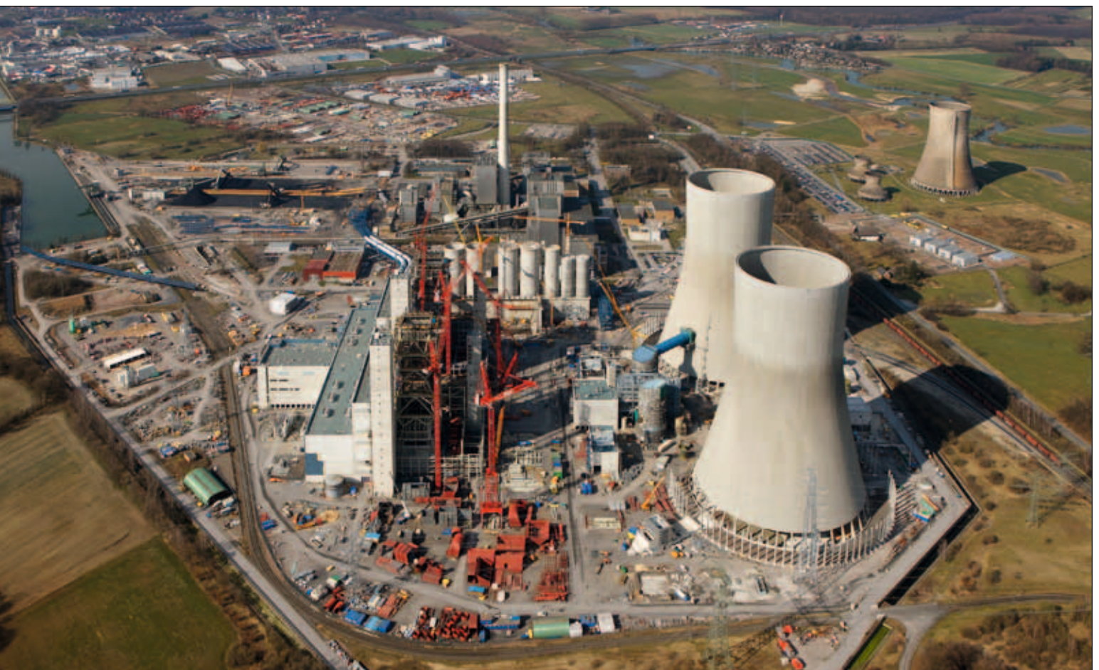
größte Baustelle: Die beiden Steinkohle-Blöcke des RWE-Kraftwerks Westfalen sollen 2013 in Betrieb gehen.
