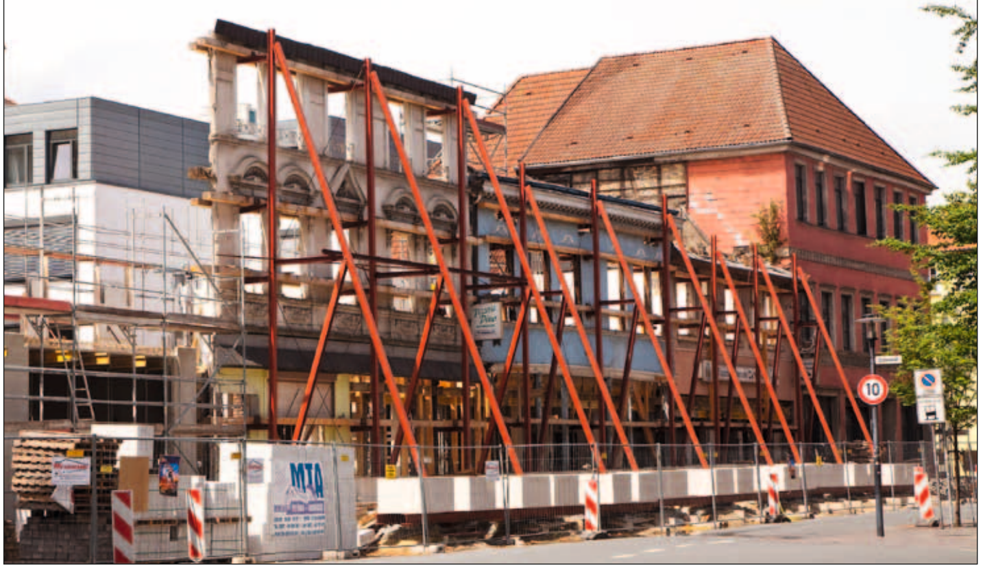
Eine tonnenschwere Stahlkonstruktion sichert die historische Fassade an der Südstraße, wo das „Medicum“ entsteht.
