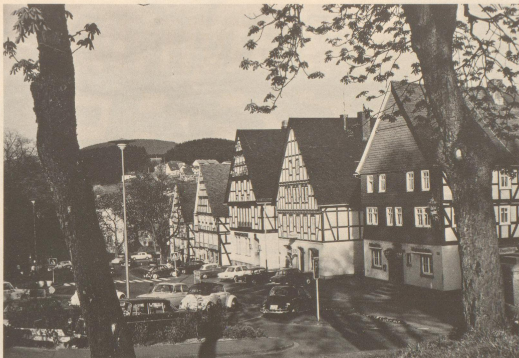
Hilchenbach: Charakteristisch für den Marktplatz sind die gepflegten Fachwerkhäuser.
