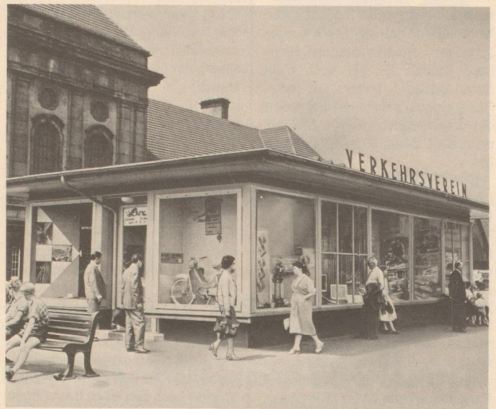
Bereits zwei Jahre nach seiner Gründung feierte der Verkehrsverein die Einweihung des Verkehrspavillons vor dem Hauptbahnhof.
