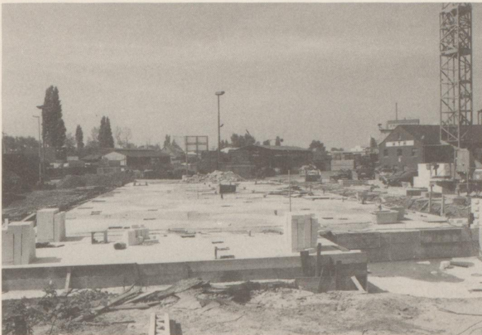
Hier entsteht das Kesselhaus des BHKW im Hafen.
