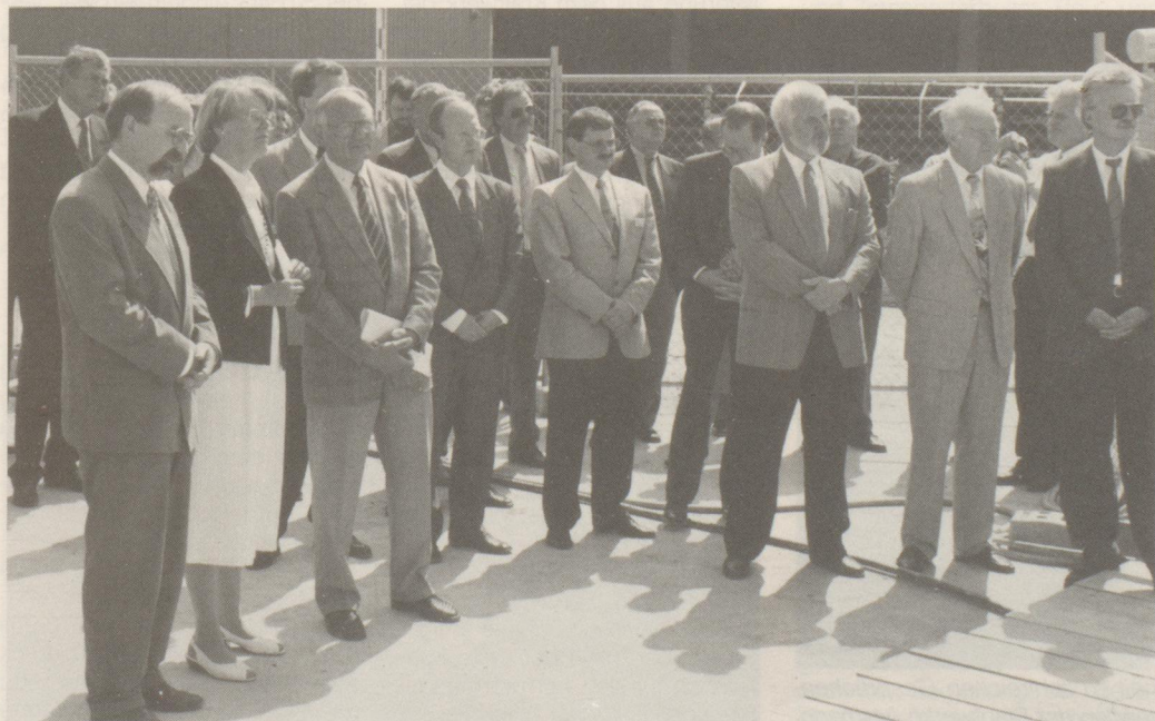
Zur Grundsteinlegung für die beiden Blockheizkraftwerke der Stadtwerke waren rund 170 Gäste aus Politik und Wirtschaft, von Versorgungsunternehmen sowie von den am Bau beteiligten Unternehmen geladen.
