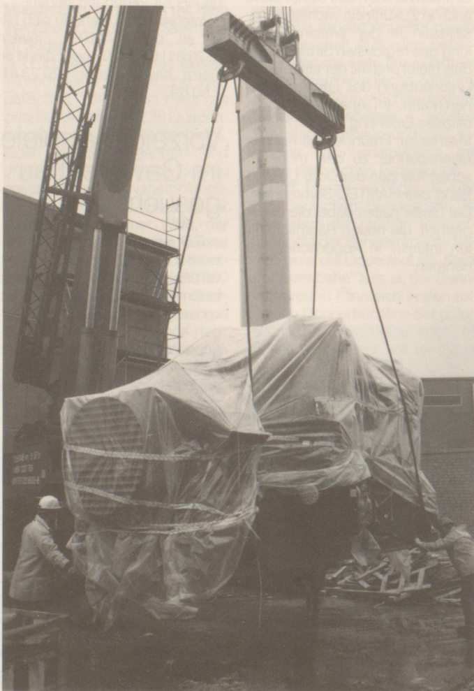
Unter schwierigen Bedingungen mußten die Motoren vom Tieflader ins Motorenhaus befördert werden.
