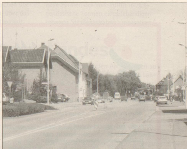
Zur Allee soll die Ahlener Straße mit Hilfe des Alleenprogramms werden, so wie sie es östlich der Bebauung schon ist.
