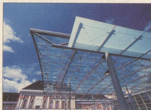
Ein gläsernes Dach überspannt den Busbahnhof.
