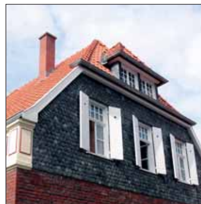
Die Giebelseite des „neuen“ Dachs.
