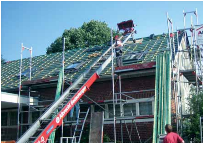
Nicht nur die Johannesschule ist in diesem Jahr eine Großbaustelle.
