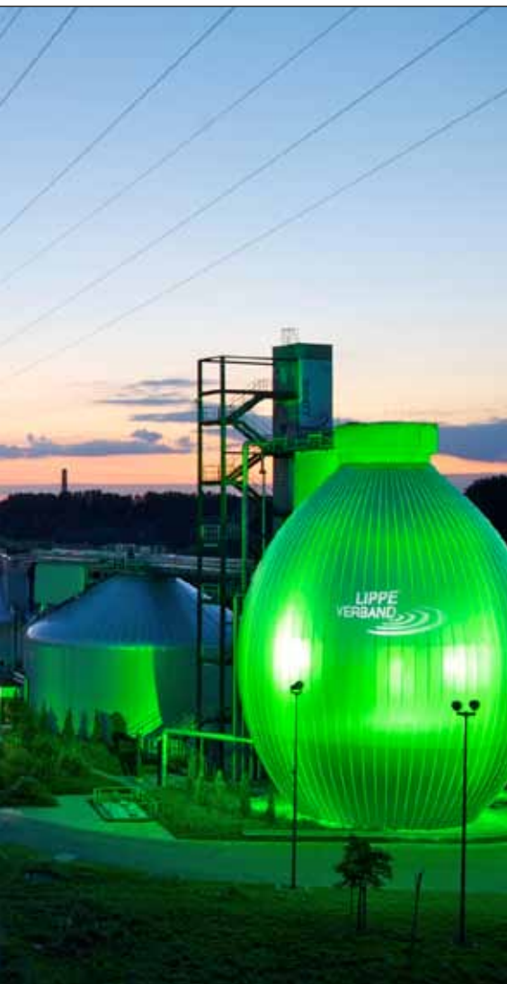
der Anlage Radbodstraße zur Schlammbehandlung
