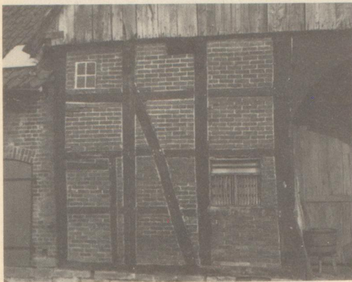
Die Restaurierung des Loh-Hofs: Das Lehmstampfgefach war Ende des 19. Jahrhunderts durch Weichbrandziegel ersetzt, das Balkenwerk mit brauner Ölfarbe überstrichen und die Stalltür zugemauert worden. Das rechte Bild zeigt die fertige Vorderfront mit verputzten und gestrichenen Feldern. Die Balken wurden mit einem hochwertigen Holzschutzmittel behandelt, Tür und Fenster erneuert.
