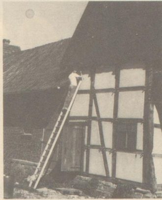
Die Restaurierung des Loh-Hofs: Das Lehmstampfgefach war Ende des 19. Jahrhunderts durch Weichbrandziegel ersetzt, das Balkenwerk mit brauner Ölfarbe überstrichen und die Stalltür zugemauert worden. Das rechte Bild zeigt die fertige Vorderfront mit verputzten und gestrichenen Feldern. Die Balken wurden mit einem hochwertigen Holzschutzmittel behandelt, Tür und Fenster erneuert.
