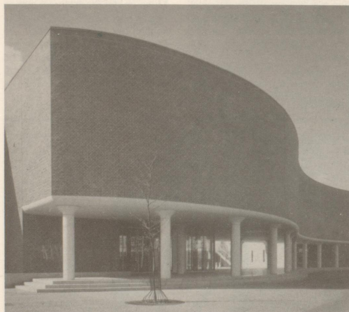
Einem Konzertflügel nachempfunden ist die Fassade zur Neuen Bahnhofstraße Foto: H. Feußner
