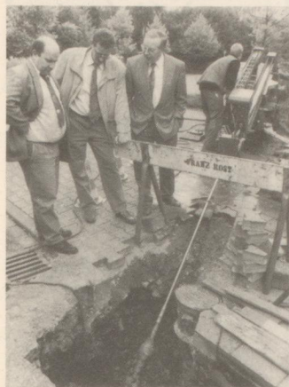
Mit Hilfe des Bohrgerätes wird von der Oberfläche aus zunächst die Pilotbohrung in die gewünschte Verlegetiefe eingebracht.
