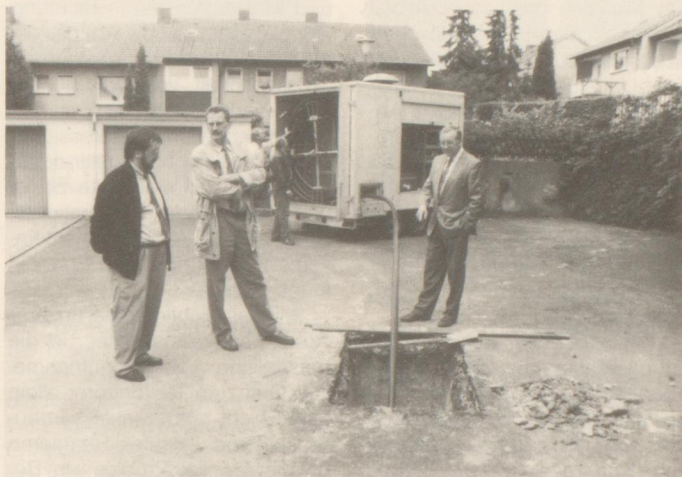
Durch die Zielgrube wird die neue Versorgungsleitung eingezogen, nachdem zuvor mit dem Aufweitkopf und nach Zurückziehen des Bohrgestänges der erforderliche Bohrdurchmesser hergestellt wurde.
