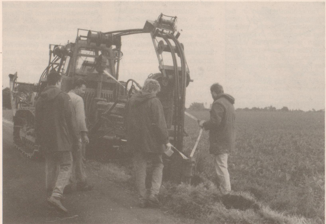
Bei günstigen Bodenverhältnissen können mit dem Kabelpflug in einem Arbeitsgang zeitgleich mehrere Kabel umweltschonend und kostengünstig verlegt werden. Die Stadtwerke haben diese Technik seit Mai bei insgesamt sieben Verlegemaßnahmen eingesetzt.
