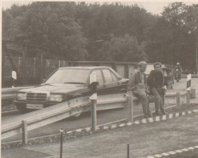
Nachdem die Kanalbrücke und damit die Fahrstraße Anfang des Jahres kurzfristig nach einer Brückenüberprüfung gesperrt werden mußte, ist seit Mitte August der Weg über die einspurige provisorische Trogbücke, die neben die alte Brücke gebaut wurde, wieder frei. Die Neubauplanung kann jetzt ohne Zeitdruck realisiert werden. Foto: L. Rettig
