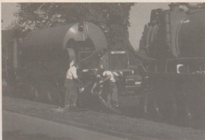
Damit das Abwasser fließen kann, wird der Kanal durchgespült Foto: Heinz Feußner
