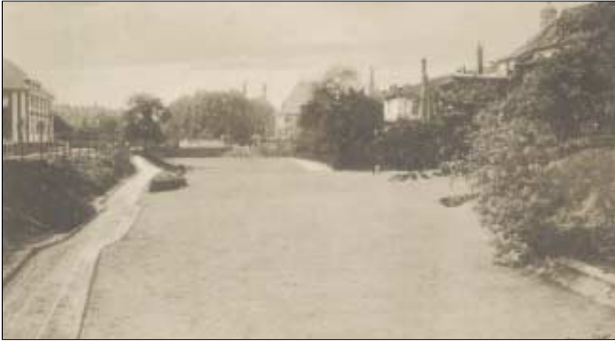
Der Südring unmittelbar nach der Fertigstellung.
