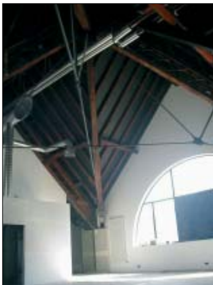
Renoviert: Die schöne alte Architektur.
